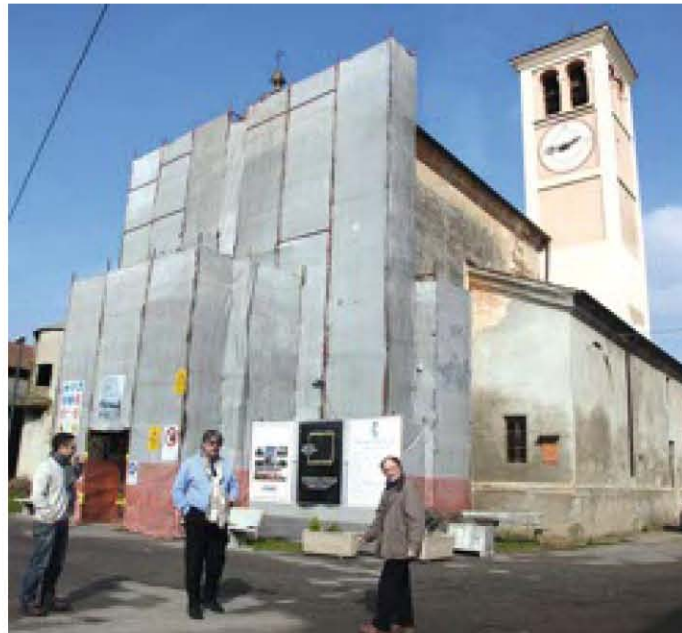
CHIESETTA L'intervento prevede anche la sistemazione dell'edificio di culto
