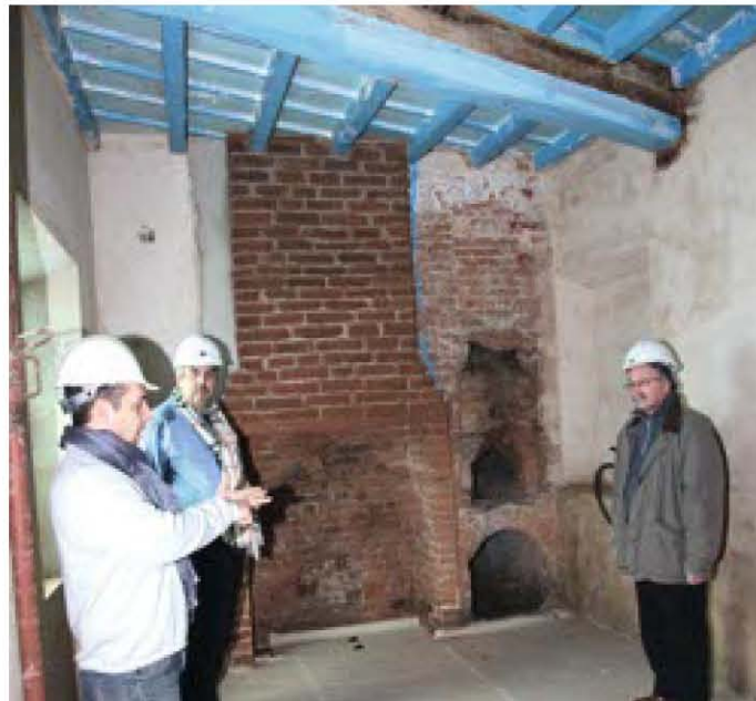
CANTIERE Una tecnica d'avanguardia per recuperare l'ex canonica
